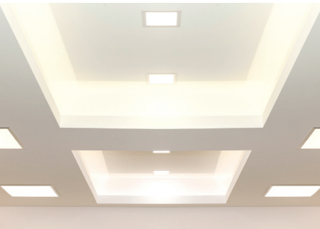
■ 屋内配線工事 (ネット配線、コンセント、照明など)
